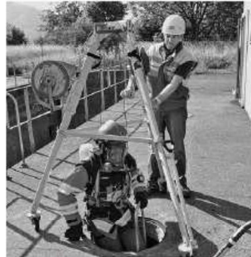
Bild 1: Beim Einsteigen in einen Schacht ist Alleinarbeit verboten. Denn im Notfall (Ersticken Gefahr) ist sofortige Hilfe nötig. Die einsteigende Person muss dauernd von einer zweiten Person überwacht werden (Richtlinie 1418.d).
